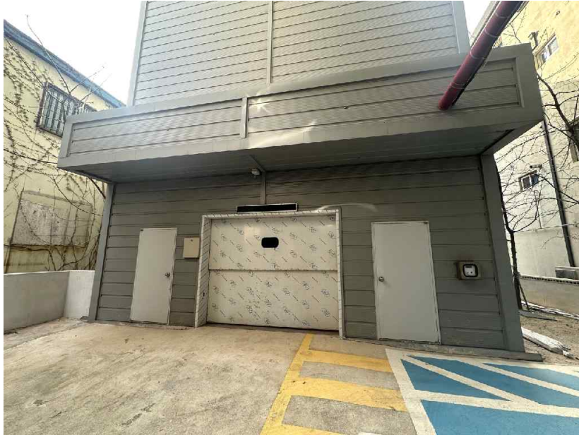
기계식 주차장 부분
